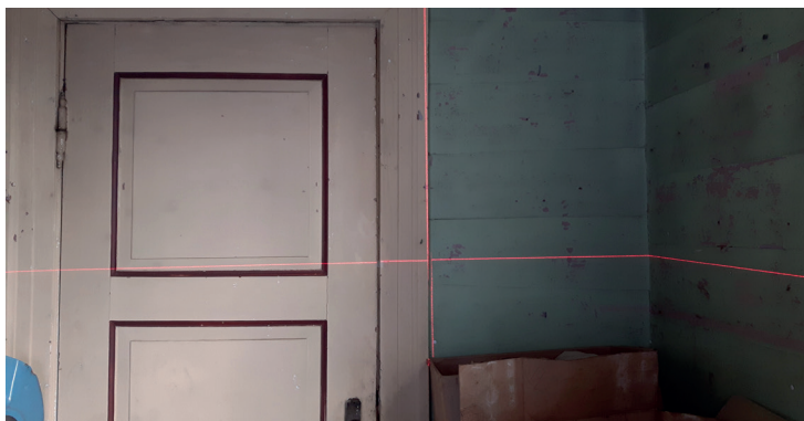
Frå oppmålingsarbeidet. Krysslaseren gir horisontal og vertikal nulllinje.
