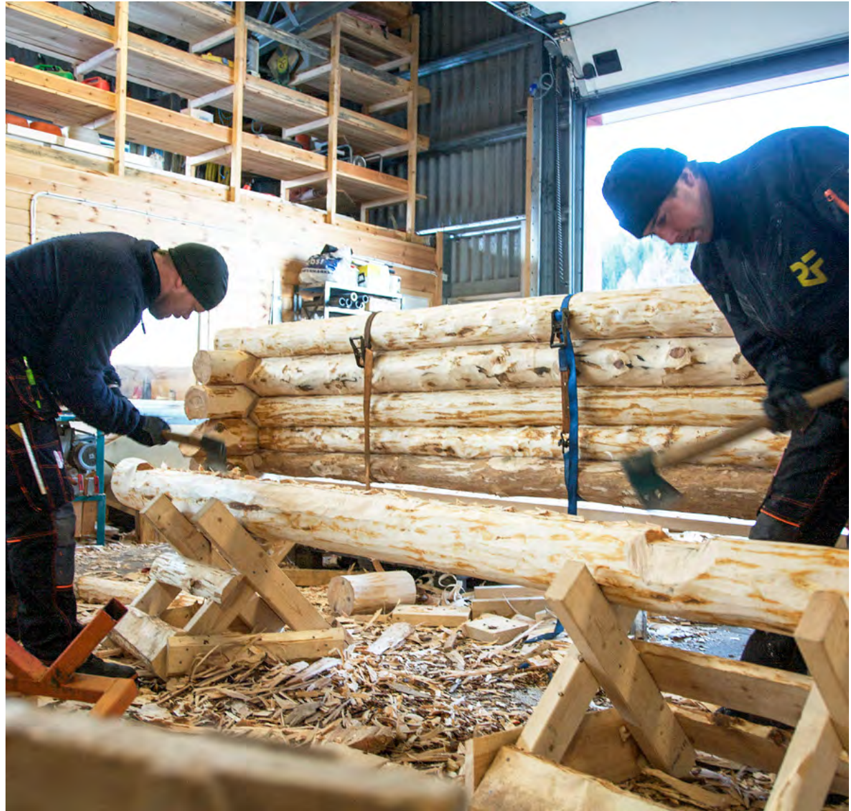
Ryfylkemuseet rekonstruerte det lafta fjaset på Røynevarden i Suldal i 2013. Det er museumshandverkarane Kjell Gunnar Haraldseid og Sven Hoftun som er i arbeid. Foto: Lise Bjelland, Ryfylkemuseet
