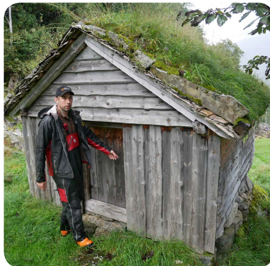
Sven Hoftun var med på tilstandsvurdering av bygningssamlinga til Ryfylkemuseet. Biletet er frå Røynevarden.
